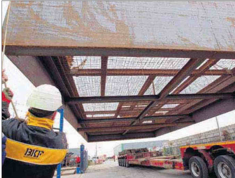
Het was een spectaculair gezicht in Zuiderzeehaven. Via een schip werd de fundering voor een 'superschaar' van Hoeben aangevoerd en vervolgens met een dieplader op zijn plek gebracht. foto Freddy Schinkel
